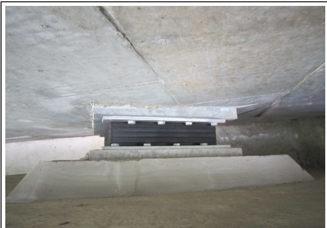
탄성받침 지지대 설치(볼트)
