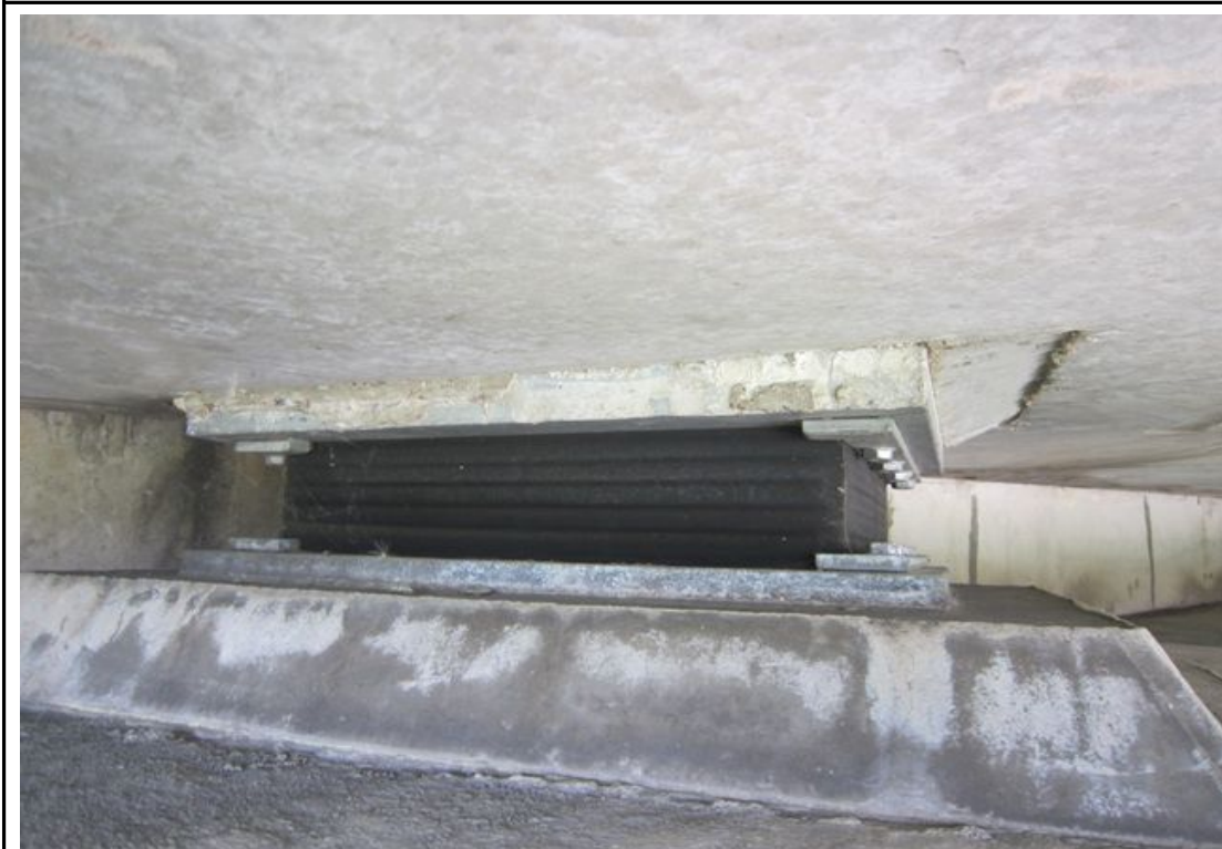
탄성받침 지지대 설치(볼트)
