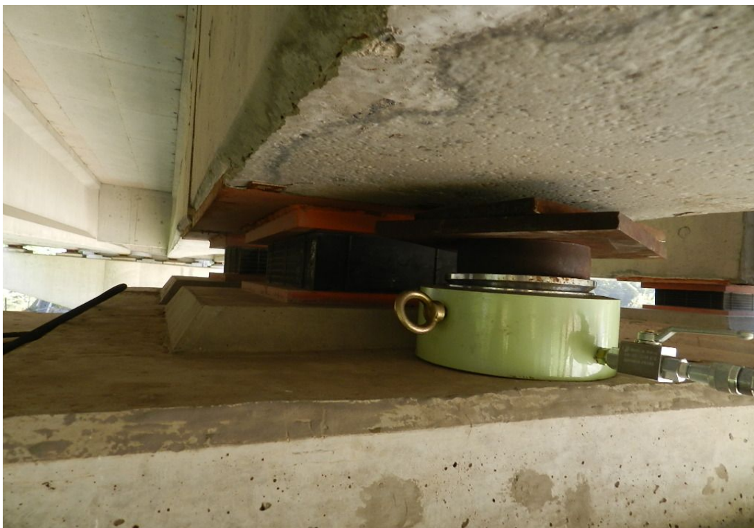
교량 인상 후 원상복구
